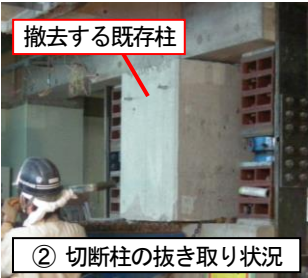
② 切断柱の抜き取り状況
