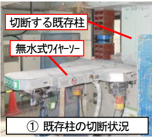
① 既存柱の切断状況
