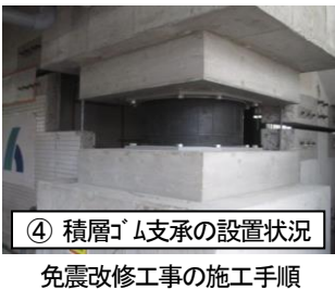
④ 積層ゴム支承の設置状況
