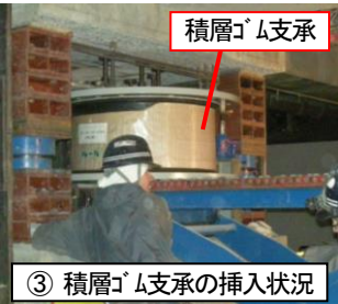
③ 積層ゴム支承の挿入状況
