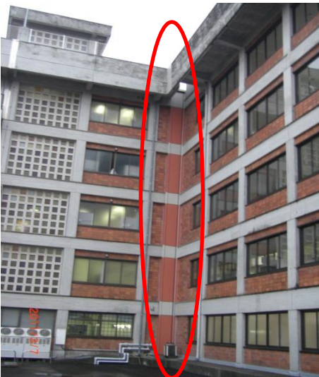
北側 切断部とのエクステンションジョイント （免震化のため 新たに設けたもの）
