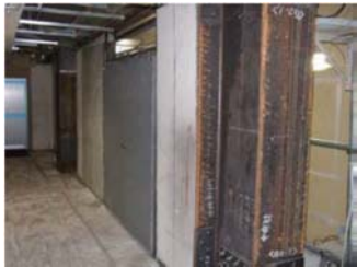
耐震間柱設置後（仕上前）
