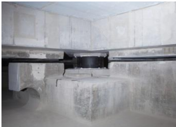
写真-2 積層ゴム設置状況
