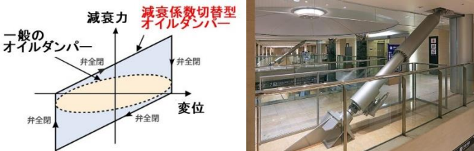
図 4. ダンパーの荷重・変位関係
