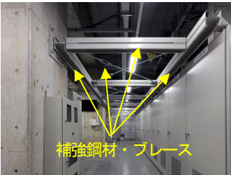
写真 7. 鋼材による低圧配電盤(左)・設備配管(右)の補強
