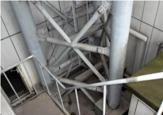
写真 3. 屋上防災無線鉄塔の補強 補強前(左)・補強後(右)
