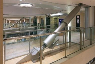
写真 2. ダンパーの設置状況
