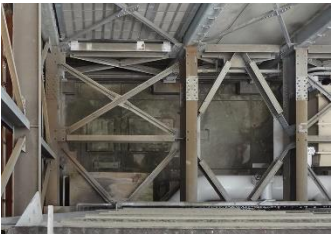
写真 4. 本体建物と冷却塔架構の連結 補強前(左)・補強後(右)
