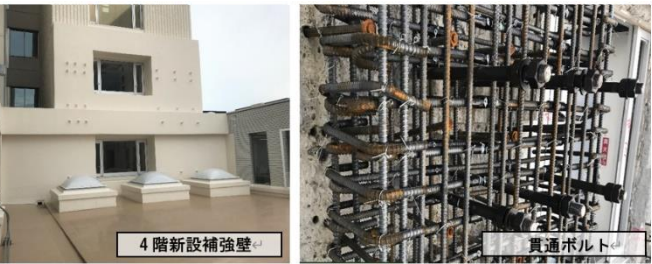
図 2・写真 2 EV 棟の既存外壁と新設耐震壁との一体化補強
