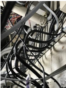
写真 5 設備配線類の余長確保
