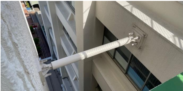
写真 3 EV 棟 (左) と庁舎 A 棟 (右) と間に設置した連結制震装置
