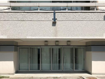
写真 4 1 階柱補強、免震水平スリット、窓サッシュ更新
