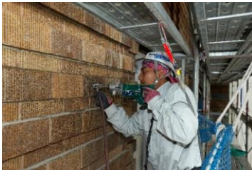
スクラッチタイルのピンニング固定
