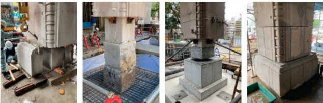
写真 3～6 正面庇柱脚改修状況
