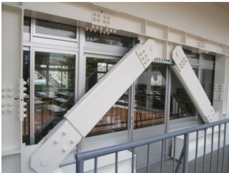
写真 2 粘弾性ダンパーブレース取付状況
