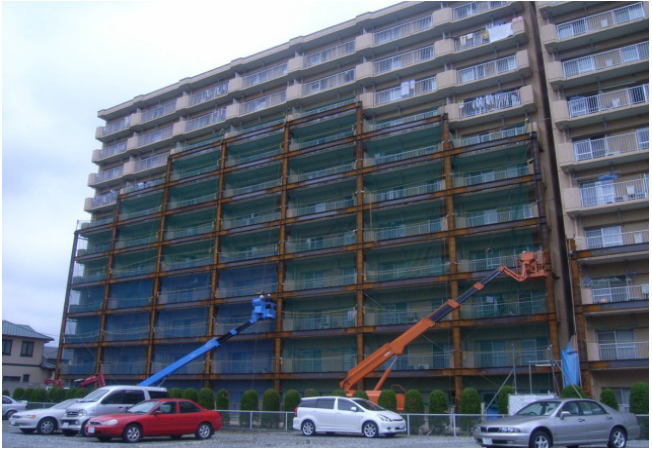
南側アウトフレーム施工状況
