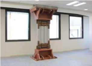
鋼製パネルダンパー制震間柱
