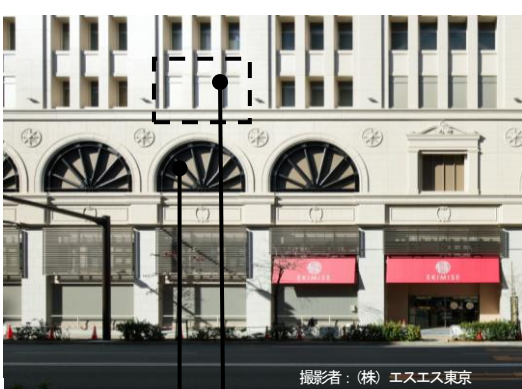
写真5 外付けブレースおよび鋼板耐震壁
