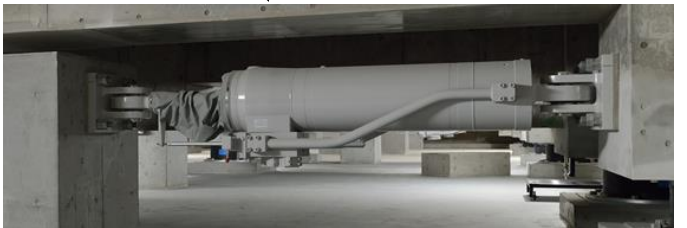
図 5 免震ビット（改修後）
