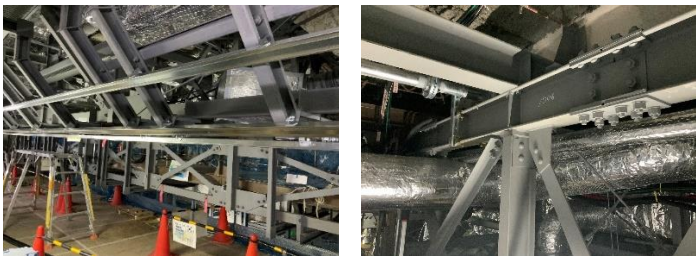
写真 - 2 支持構造部材の施工状況
