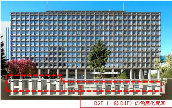
写真 2. 改修後断面（地下部分断面は CG）
