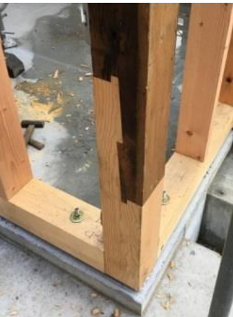
写真-5 金輪継手
