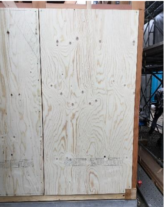
写真-4 改修後 構造用合板壁
