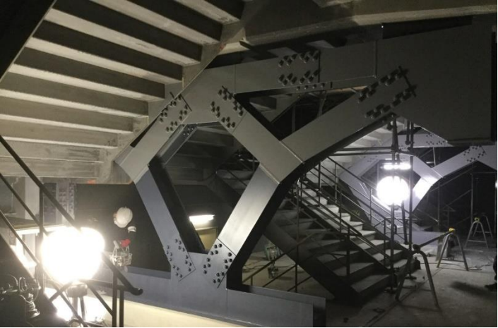
写真 3：鉄骨ブレース補強
