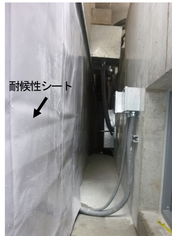
地下のドライエリア（左 外壁、奥 擁壁、右 下屋）
