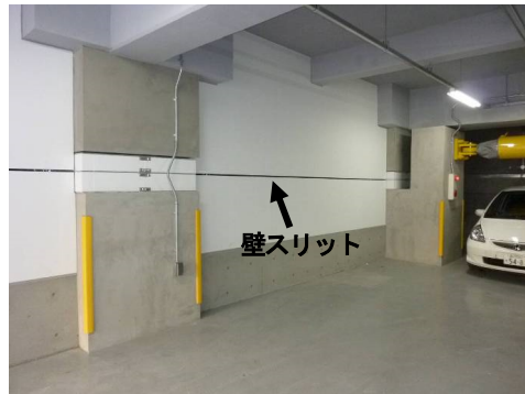
地下1階免震装置と壁
