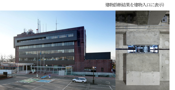
写真 6 B1 階柱切断状況
