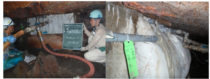
写真 2 隔壁エアミルク注入状況（試験施工）
