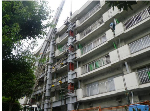
鉄骨フレーム建方
