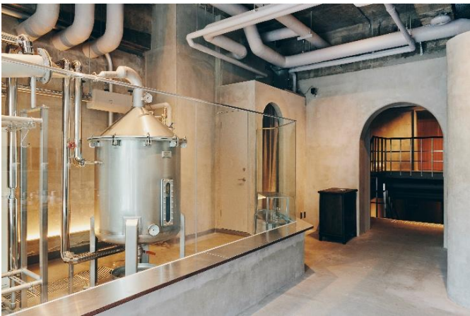
写真-2 エントランスのアーチ型の耐震壁
