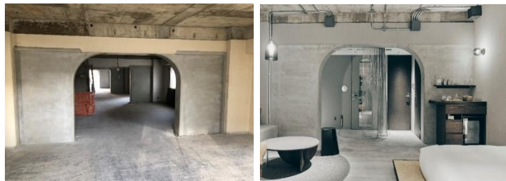
写真-3 アーチ耐震壁(施工中)
