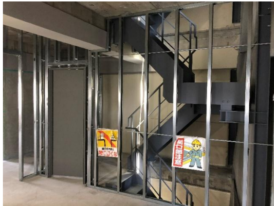
写真-5 追加された階段(施工中)
