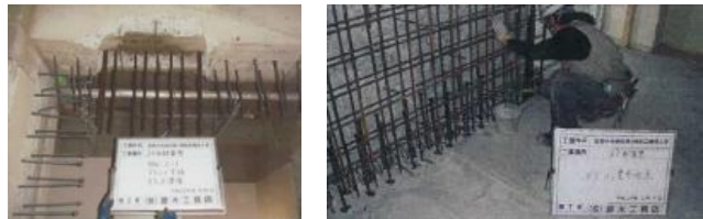
(左) 耐震壁部 フランジ下端スタッド溶接状況
