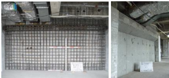
耐震壁新設 鉄筋組 コンクリート打設完了
