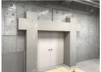
壁増し打ち及び開口部補強の柱、まぐさ新設
