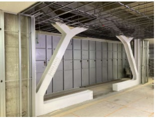
内付鉄骨ブレース(マンサード型) 取付状況 同 竣工写真
