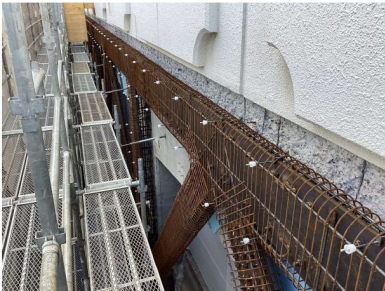
ピタコラム工法 施工写真
