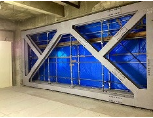
内付鉄骨ブレース(K型) 取付状況
