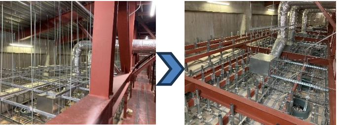
写真一③ 改修前・改修後の補強部材・準構造部材の設置状況
