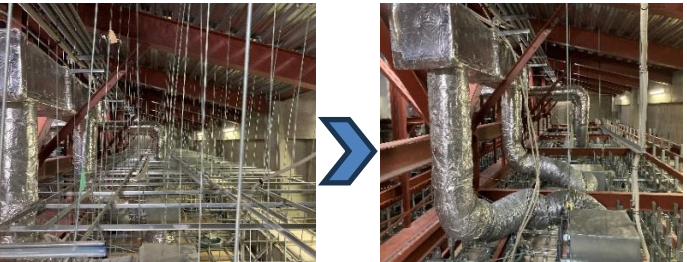
写真一② 改修前・改修後の天井内支持構成部材の設置状況
