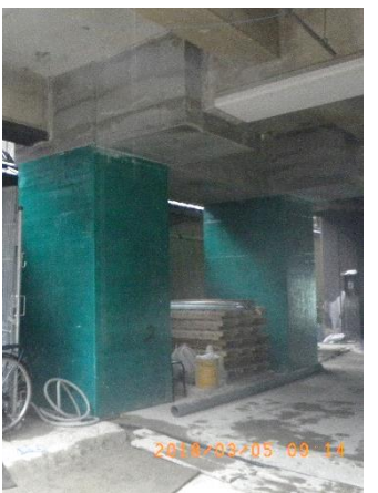
耐震補強完了
