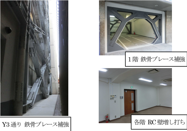
写真－3 各種補強写真
