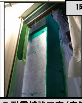
柱HP耐震補強工事(店舗内外施工状況)
