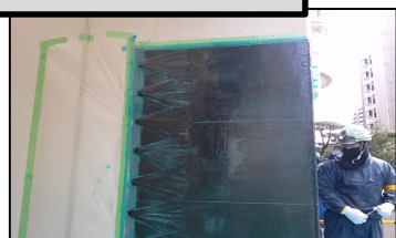
柱炭素繊維補強工事 CFアンカー
