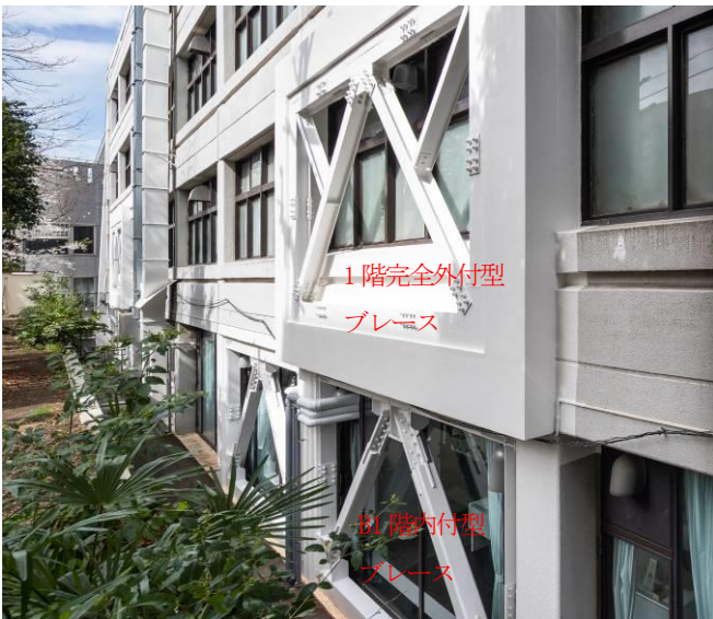
写真-2 B1・1階 鉄骨ブレース設置外観写真
