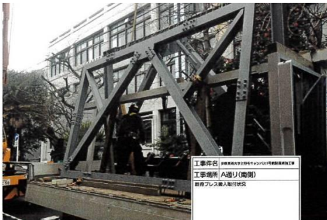
写真-4 鉄骨ブレース搬入写真
