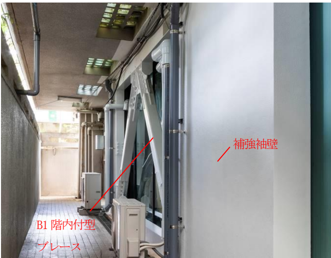
写真-3 B1階 鉄骨ブレース・RC袖壁設置写真
