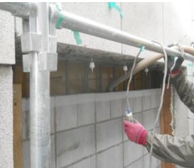
充填モルタル打設状況
