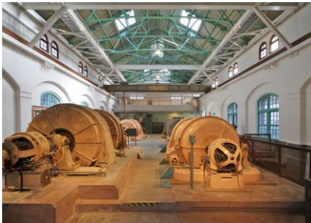
写真－4 改修後 小屋下水平面鉄骨補強状況
