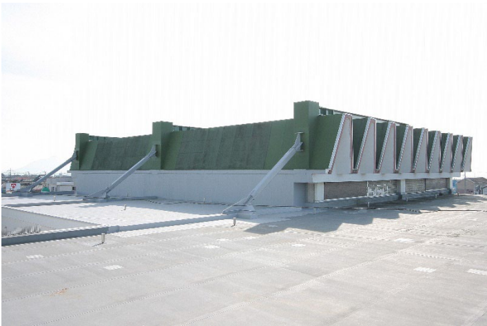
写真-2 屋上バットレス改修後
