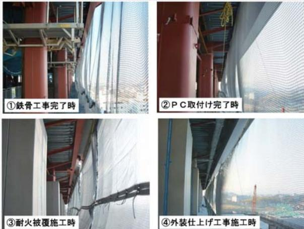
写真-4 各STEPの外周養生写真
