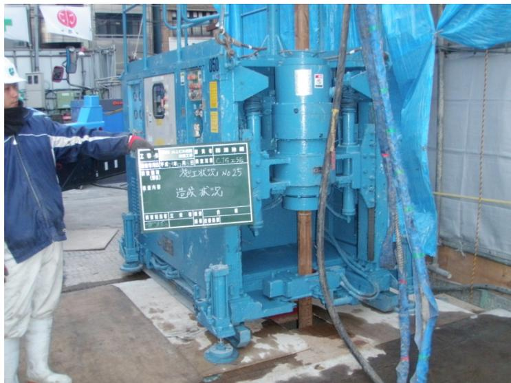
写真-3 C J G工法による柱列施工状況
