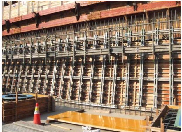
写真-2 システム型枠設置状況
