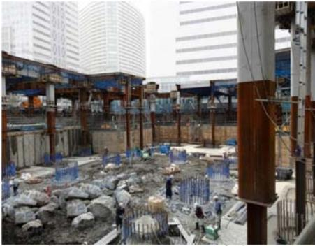
写真4 仮設支柱による建方状況
