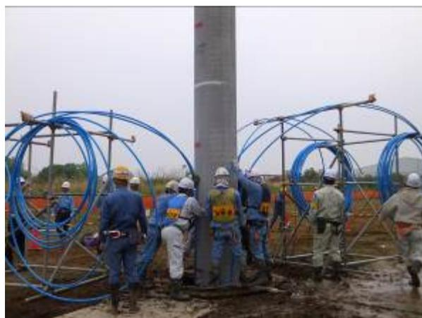
写真－7 採熱管用仮設ハンガー
