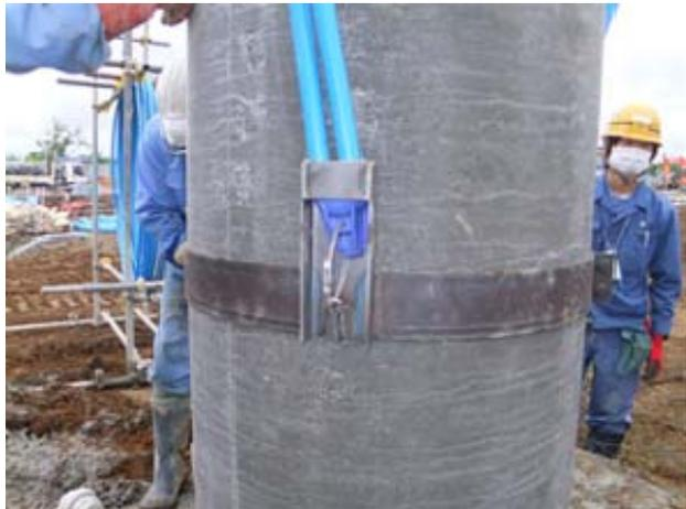
写真-5 先端部のプロテクター
