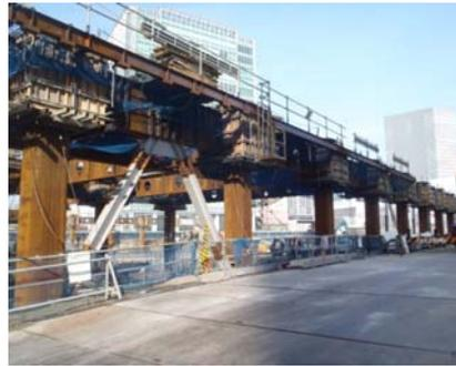
写真3 NS工法を用いた建方状況
