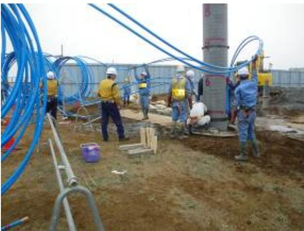
写真-4 地中熱採熱管設置状況
