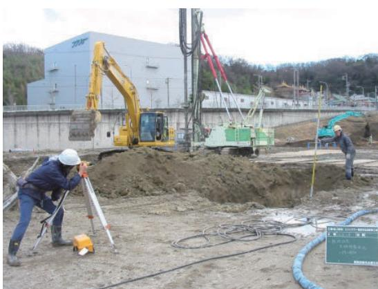
写真-7 従来工法杭頭処理状況
