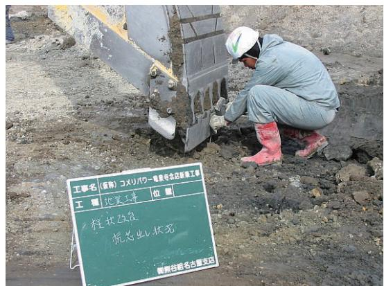
写真-6 バケットによる杭芯位置出し
