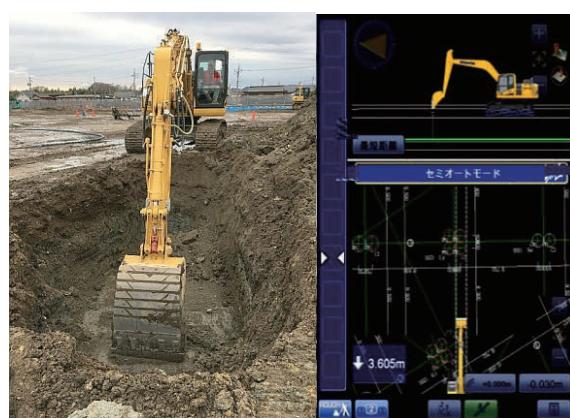
写真-8 ICT建機による杭頭レベル確認
