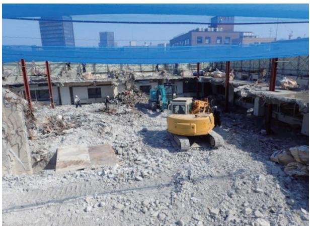
写真-5 支柱固定部スラブ解体
