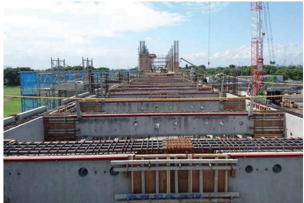
写真5 仕口部型枠状況
