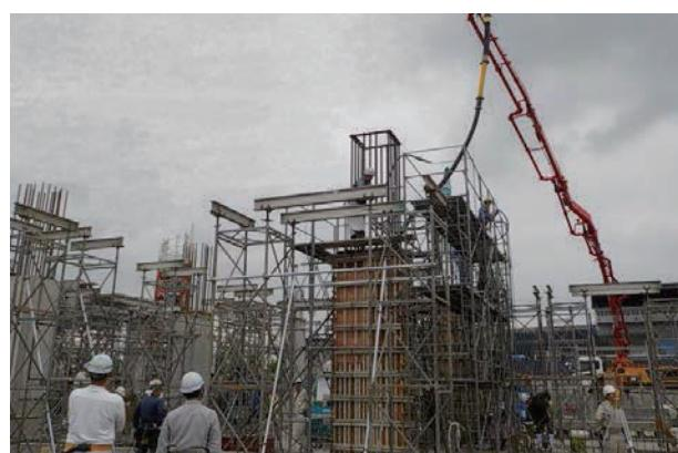
写真1 柱コン打設状況
