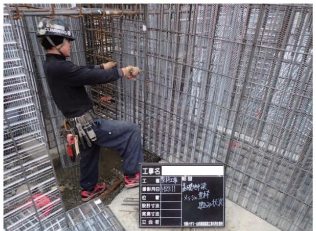
写真-6 メッシュ型枠施工状況
