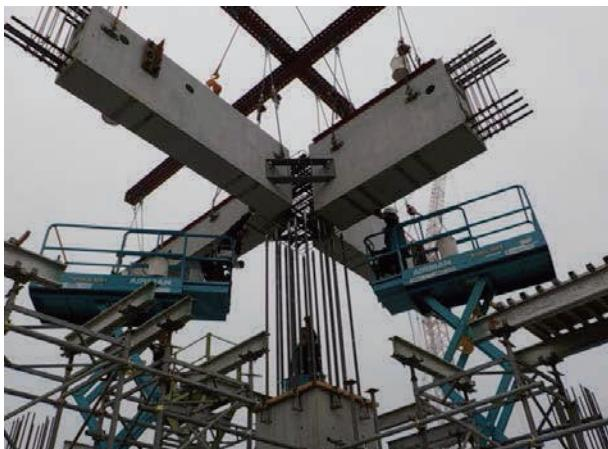
写真3 PCa梁取付状況
