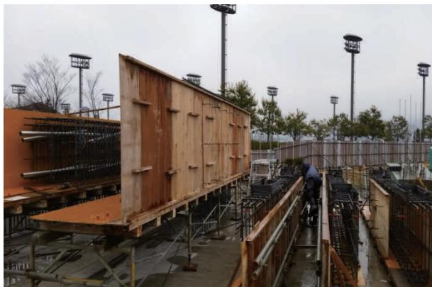
写真-7 梁筋及び型枠ストック状況
