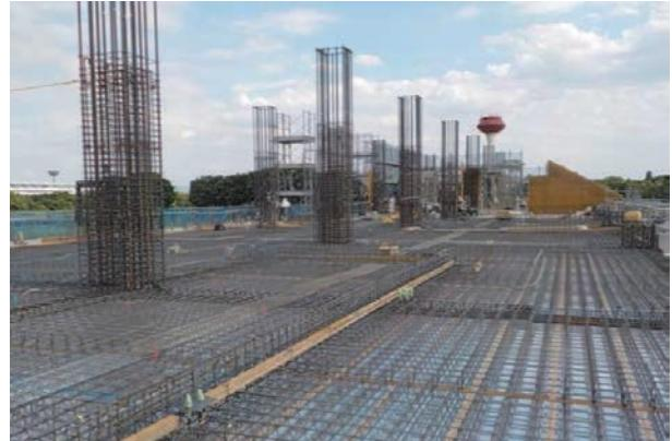
写真6 スラブ・柱配筋状況
