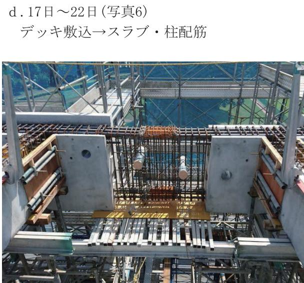
写真4 鉄筋嵌合状況
