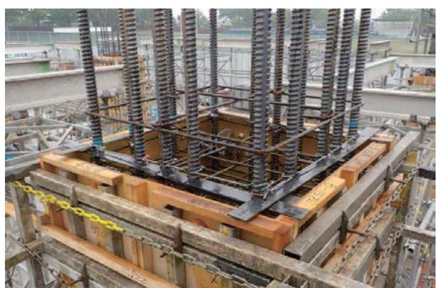
写真7 柱筋固定状況
