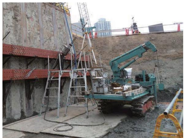
写真2 地盤アンカー引抜き試験状況
