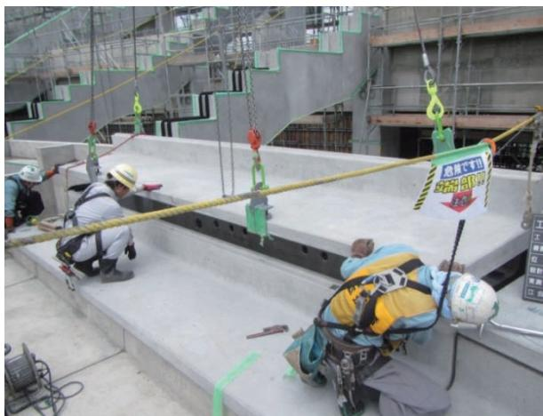
写真-5 PCa段床建方状況
