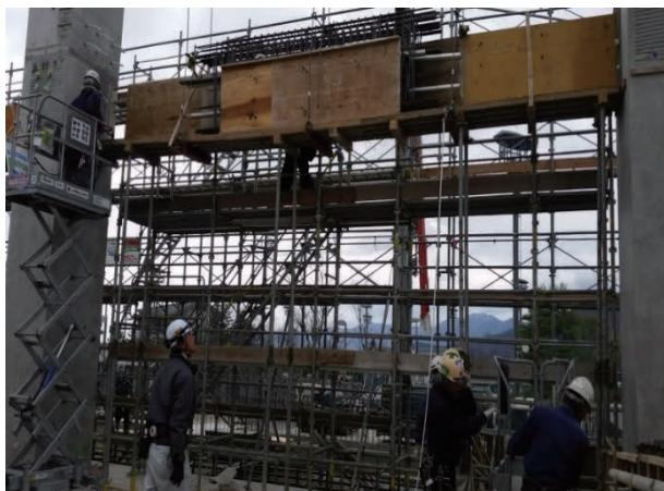
写真-8 梁筋及び型枠の一体取付状況
