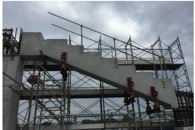
写真9 段梁支保工施工状況
