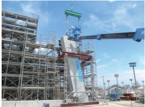
写真-3 PCa斜め柱建方状況
