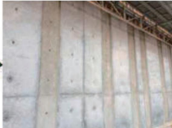
写真-9 型枠脱型後の打ち放し壁面
