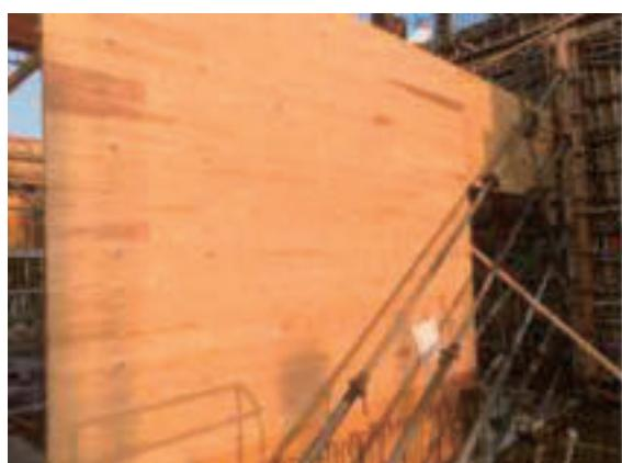
写真-4 杉板浮造り型枠組立状況
