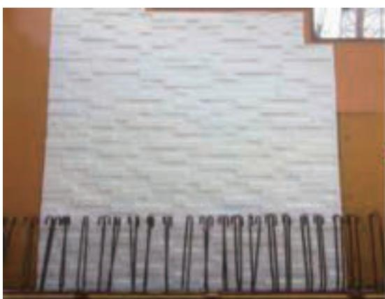
写真-10 化粧型枠（造形ボード）組立状況
