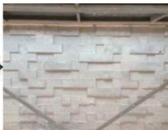
写真-11 型枠脱型後の打ち放し壁面
