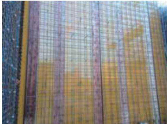
写真-8 凹凸化粧型枠組立状況
