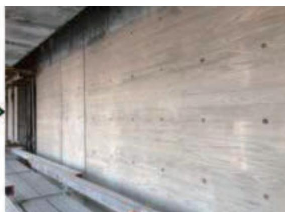
写真-5 型枠脱型後の浮造り仕上げ面
