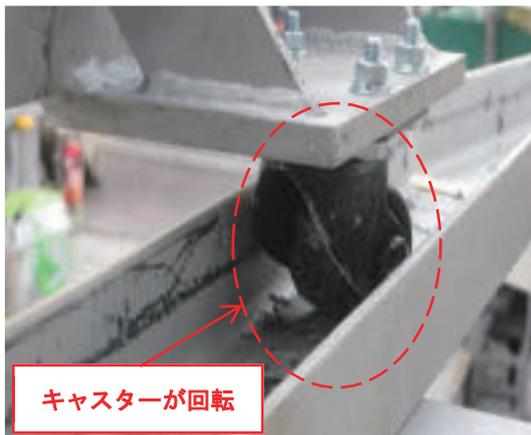
写真 8 タイヤ式キャスターを使った試験施工状況
