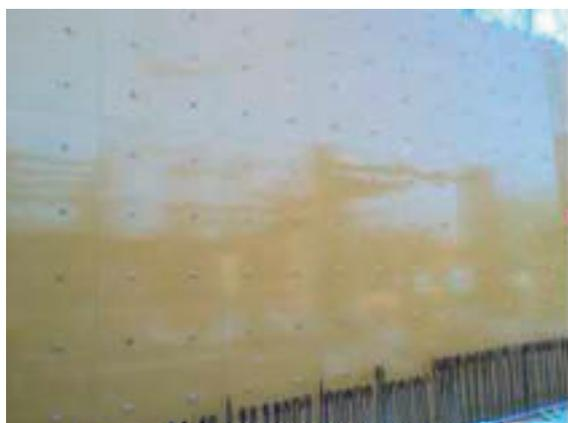
写真-6 化粧型枠組立状況
