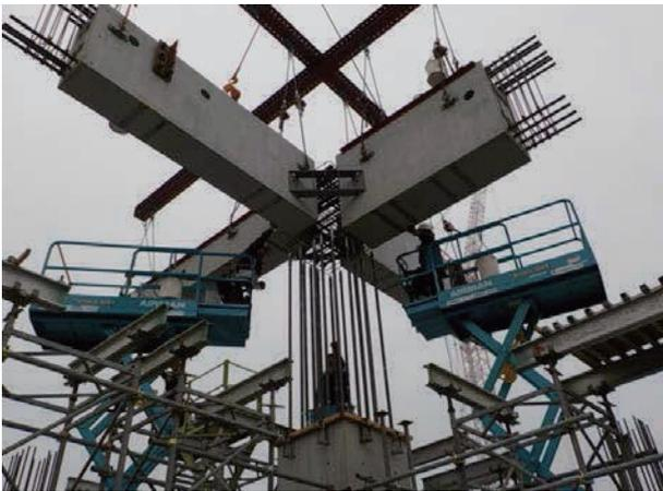
写真3 PCa 梁取付状況
