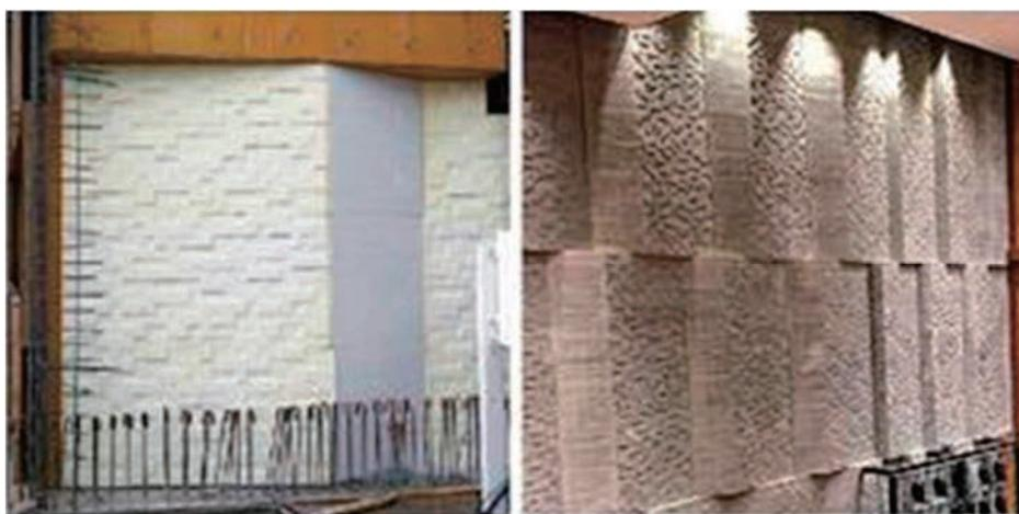
写真-15 大ホール側壁面（左：造形ボード型枠 右：型枠脱型状況）
