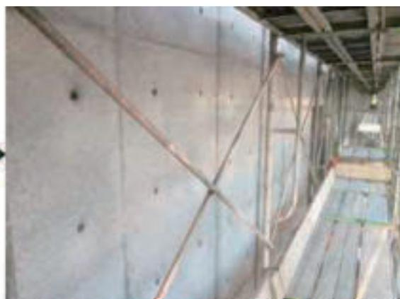
写真-7 型枠脱型後の打ち放し壁面
