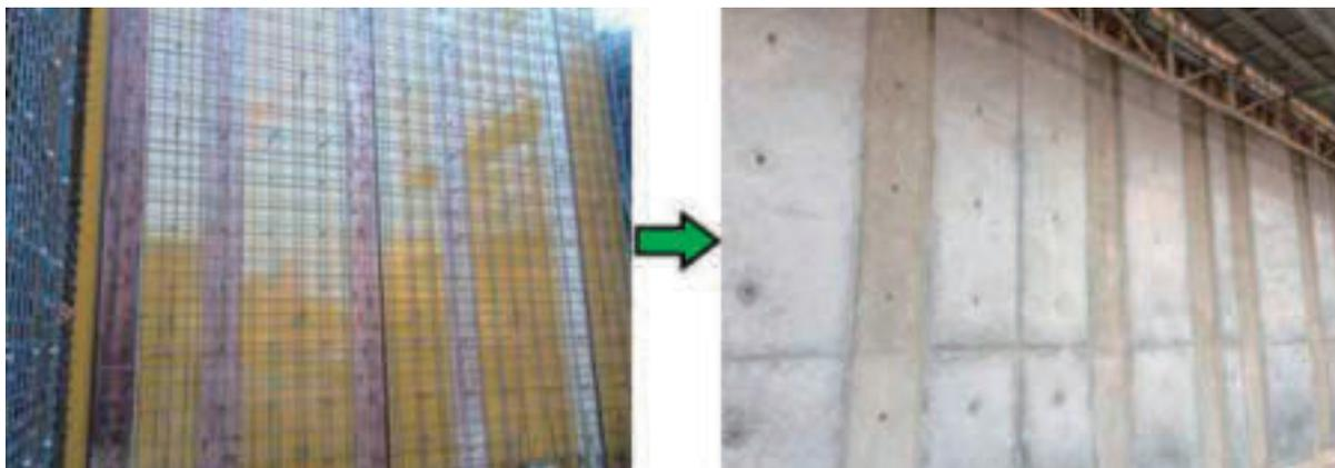
写真-8 凹凸化粧型枠組立状況
