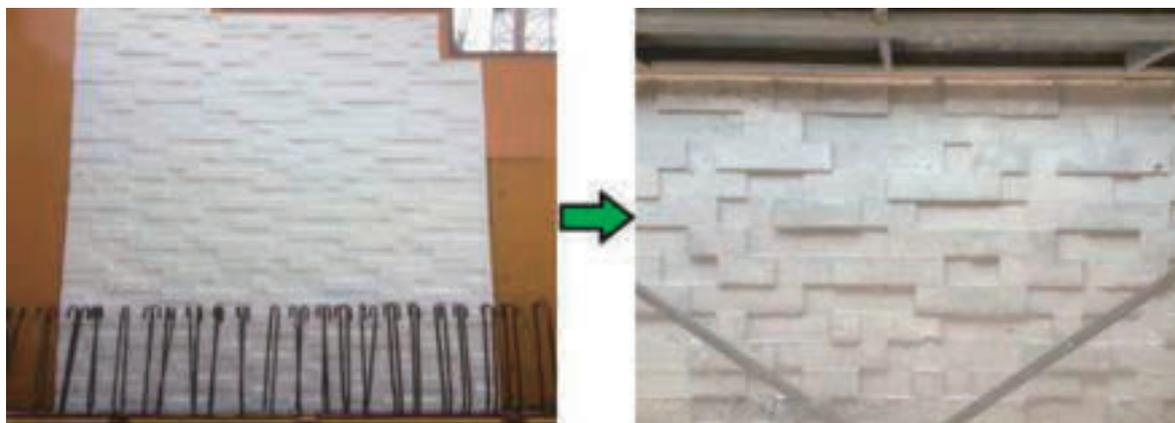
写真-10 化粧型枠 (造形ボード) 組立状況
