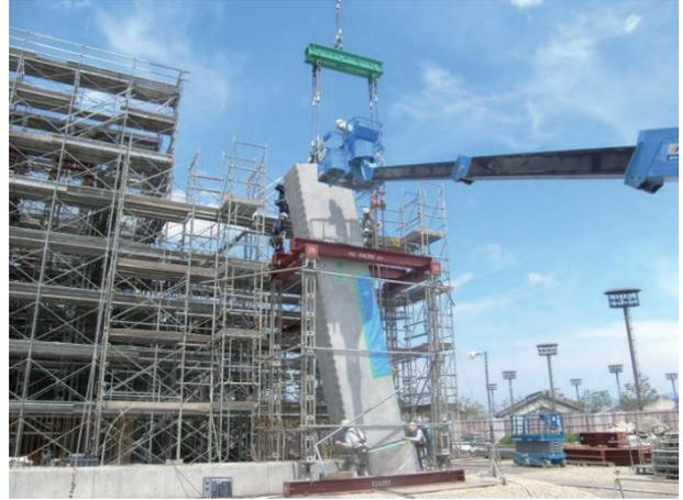
写真-3 PCa斜め柱建方状況
