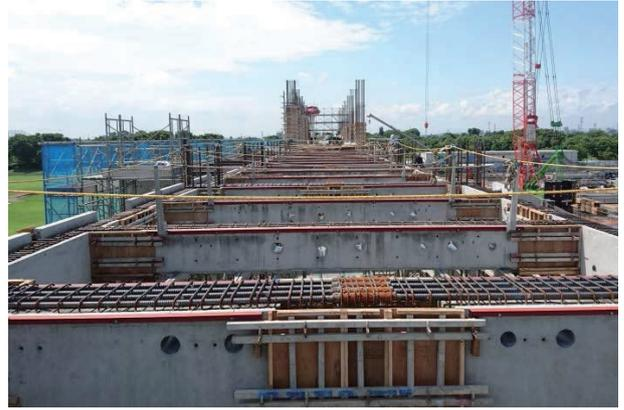
写真5 仕口部型枠状況
