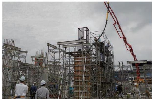
写真1 柱コン打設状況
