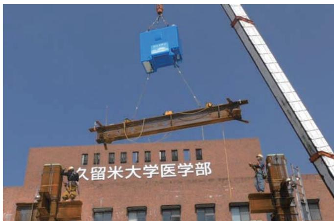
写真-11 吊荷旋回制御装置使用状況
