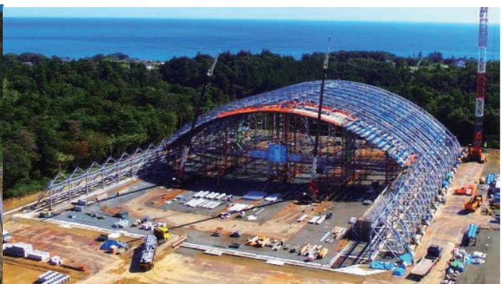
写真—5 鉄骨組立状況2
