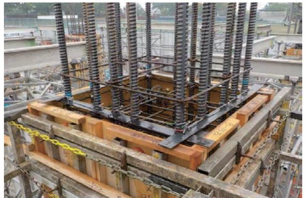
写真7 柱筋固定状況
