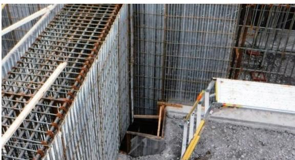
写真-6. 地中梁鋼製ラス型枠施工状況
