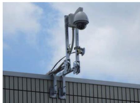
写真-4 Webカメラ設置状況
