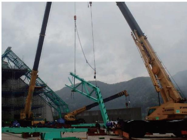
写真-6 斜めトラスユニット玉掛け状況
