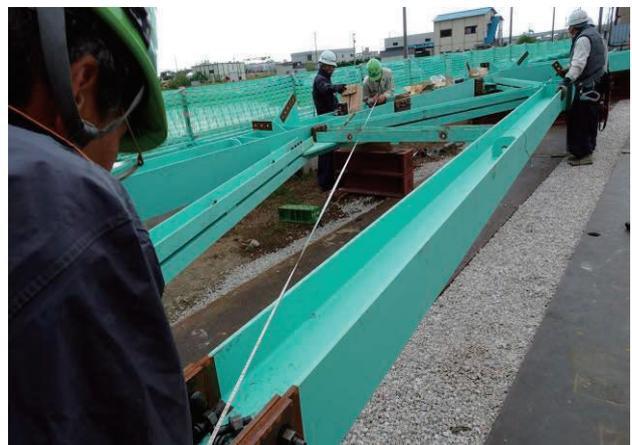
写真-3 トラス地組本締め前 寸法調整
