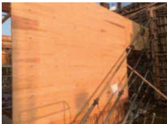
写真-4 杉板<sup>うづく</sup>浮造り型枠組立状況
