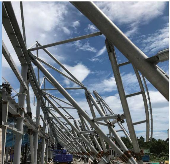
写真—7 柱脚部鉄骨組立状況
