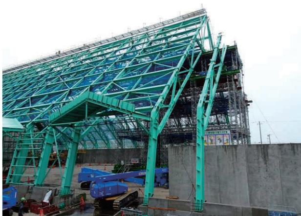
写真-8 斜めトラスユニット据付完了
