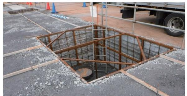
写真-5. 基礎鋼製ラス型枠施工状況
