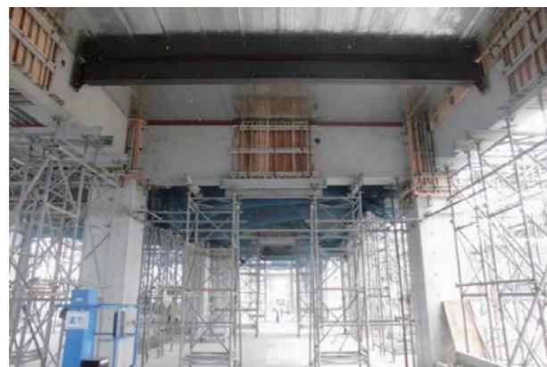
写真11 大梁仕口型枠施工状況
