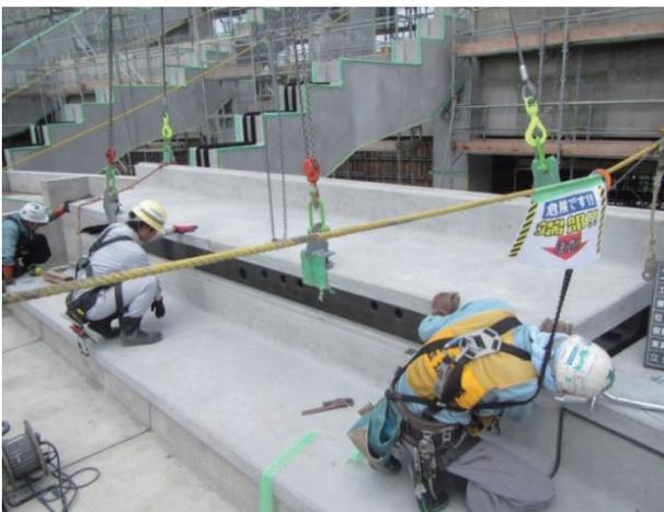
写真-5 PCa段床建方状況
