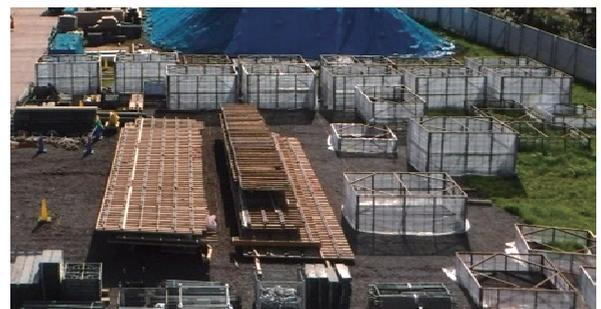
写真-7. 外周ユニット型枠および基礎鋼製ラス型枠
