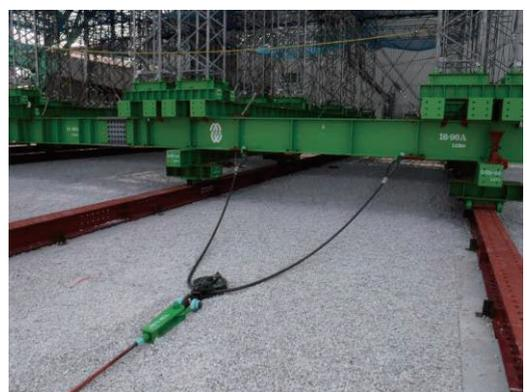
写真-13 牽引治具取付け状況
