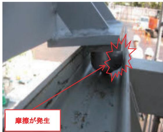
写真 10 ボールキャスターを使った試験施工状況
