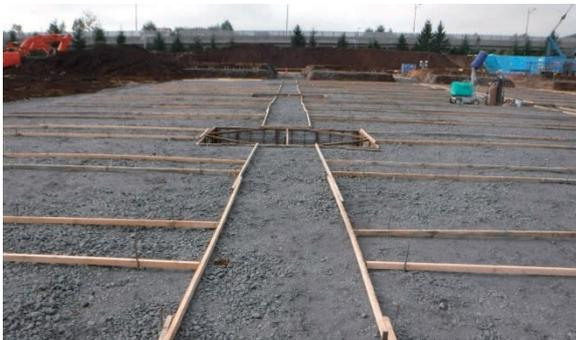
写真-3. 掘削床付け状況
