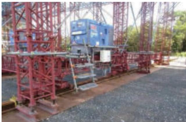
写真—11 移動式支保工足場ジャッキポスト&レール
