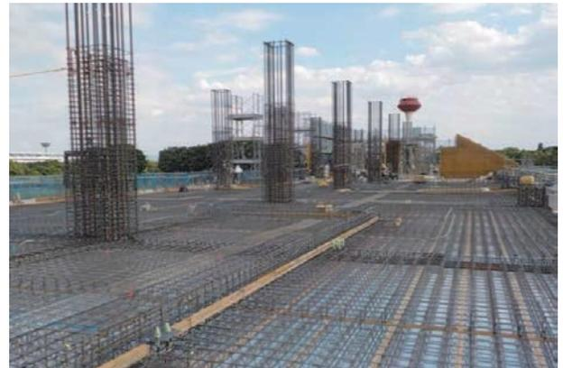
写真6 スラブ・柱配筋状況
