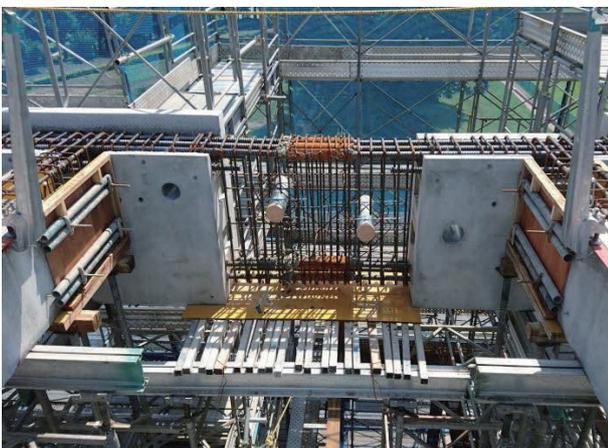
写真4 鉄筋嵌合状況
