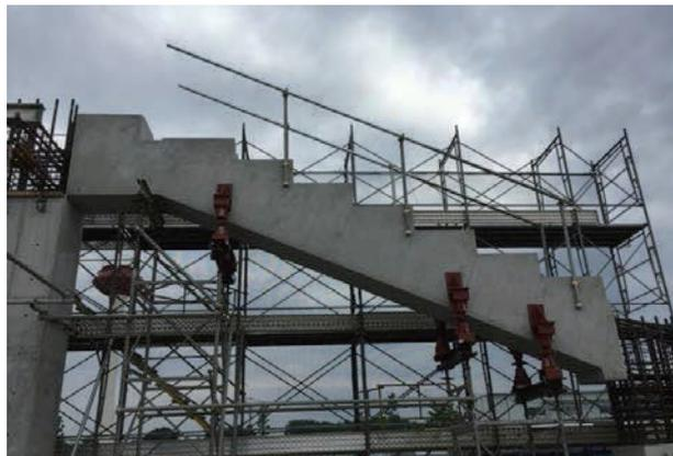
写真9 段梁支保工施工状況
