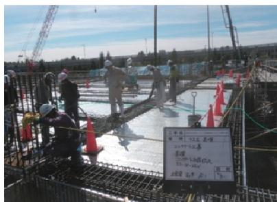
写真-10. 地中梁コンクリート打設状況
