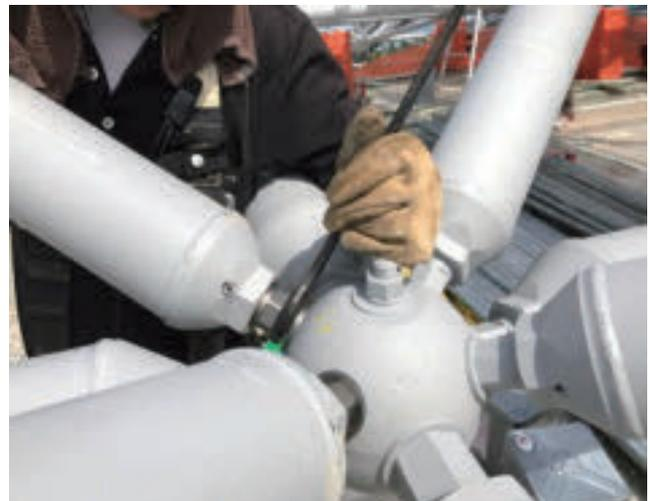
写真—9 パイプ鉄骨接合 ボールジョイント部組立
