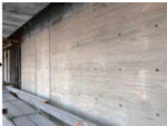
写真-5 型枠脱型後の<sup>うづく</sup>浮造り仕上げ面
