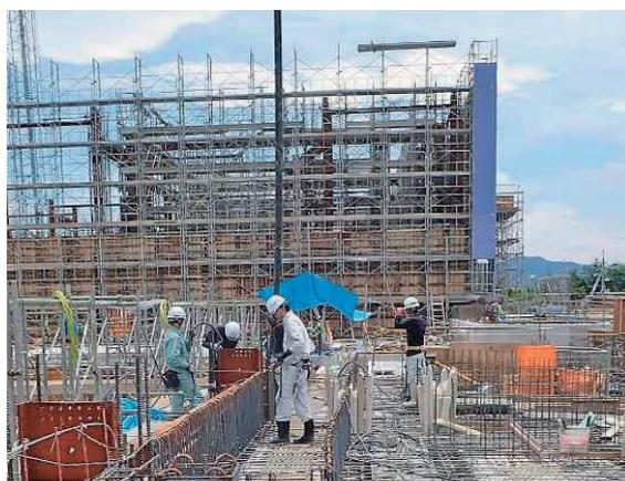
写真-3 コンクリート打設状況
