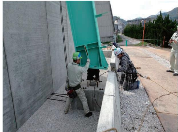
写真-7 柱脚据付状況
