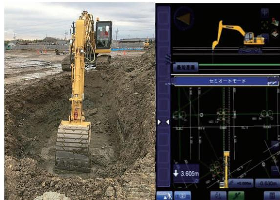
写真-8 ICT建機による杭頭レベル確認
