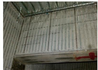
写真-11. フラットデッキ下打設後
