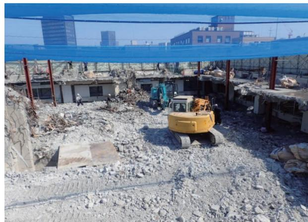
写真-5 支柱固定部スラブ解体
