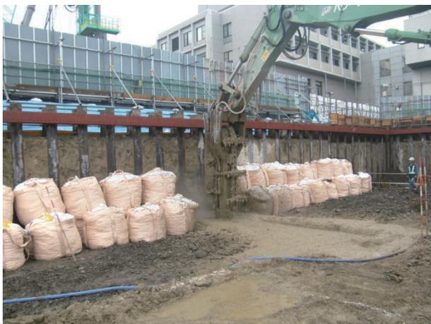
写真-6 フレコンバッグ土嚢2段積み
