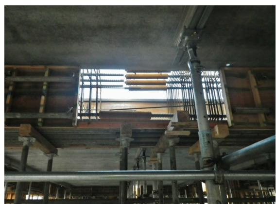
写真-8 梁側型枠脱着式
