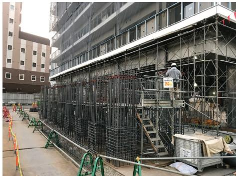
写真-4 柱鉄筋地組状況
