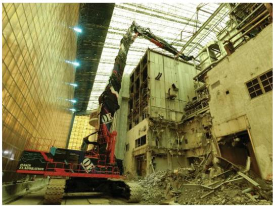
写真-2 大型圧碎機による解体状況
