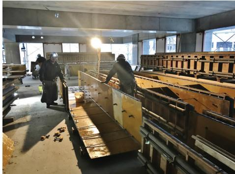
写真-1 型枠地組状況
