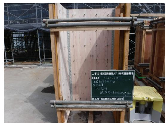
写真-12 CLT型枠仮組状況
