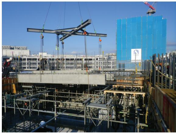
EVシャフト部の単独小梁もそれぞれサイトPCa化を試みたが、梁鉄筋継手部の処理には型枠が必要であり、施工メリットが少なく、周辺も在来スラブである為、最終的には在来工法にて施工することを選択した(写真-3)。
