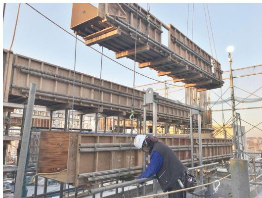
写真-10 梁型枠連吊り状況
