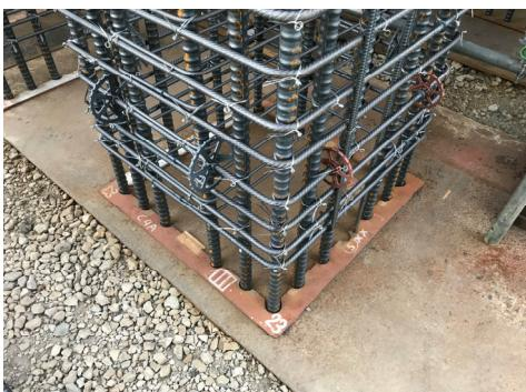
写真-5 柱筋柱脚テンプレート
