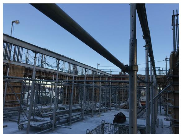
写真-13 床ハーフPCa板支保工立状況
