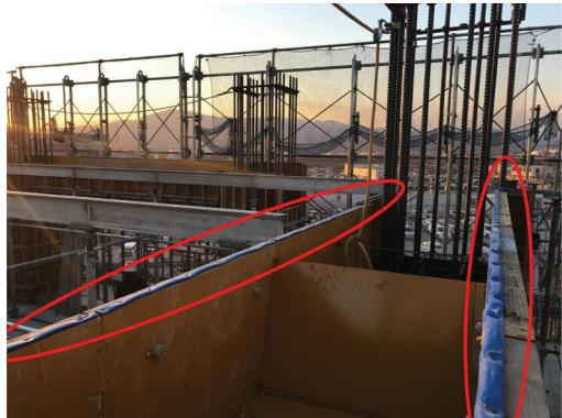
写真-14 梁型枠ゴムホース設置状況
