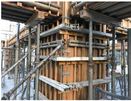
写真-9 柱締め付け金具使用状況
