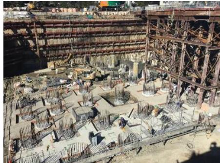
写真-6 B2F部の基礎先行施工状況
