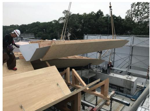
写真-6 工場地組部材 吊込みの様子
