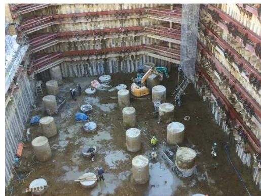
写真-5 ゴミバンカ掘削状況
