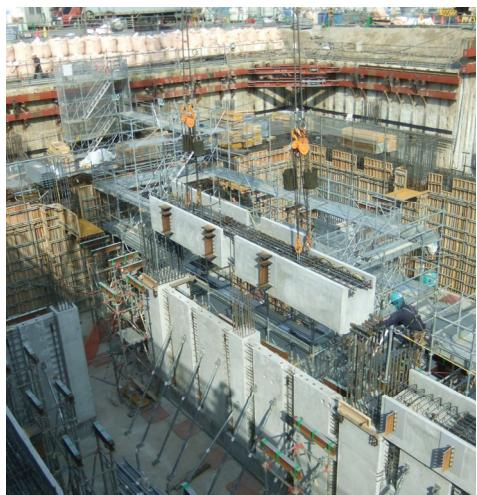
写真-7 梁PCa部材の取り付け状況
