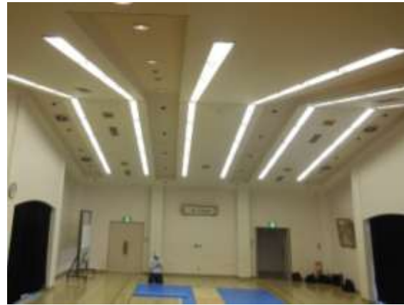
対策前の既存天井
