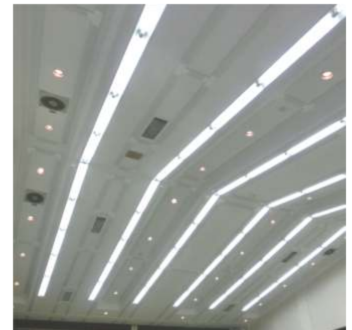
設置完了状況
