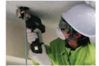
4) 吊りボルト設置
