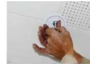
5) 仮設開口塞ぎ
