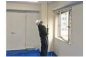
2) アンカー一部削孔
