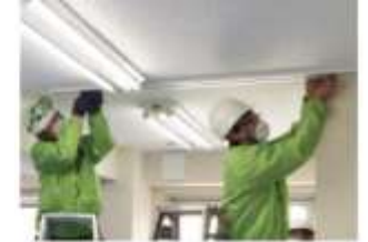
6) 水平支持部材設置
