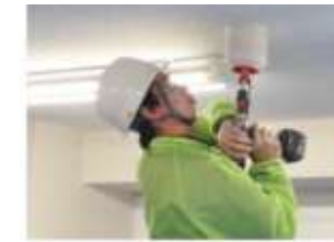
1) 仮設開口削孔
