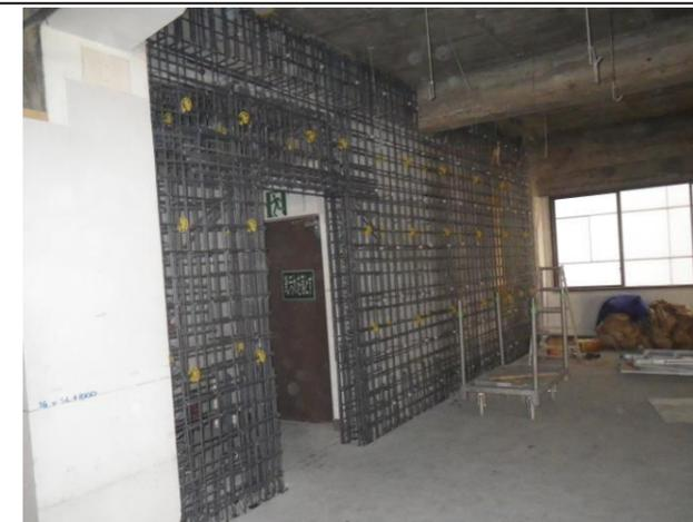
基準階 RC増し壁工法
