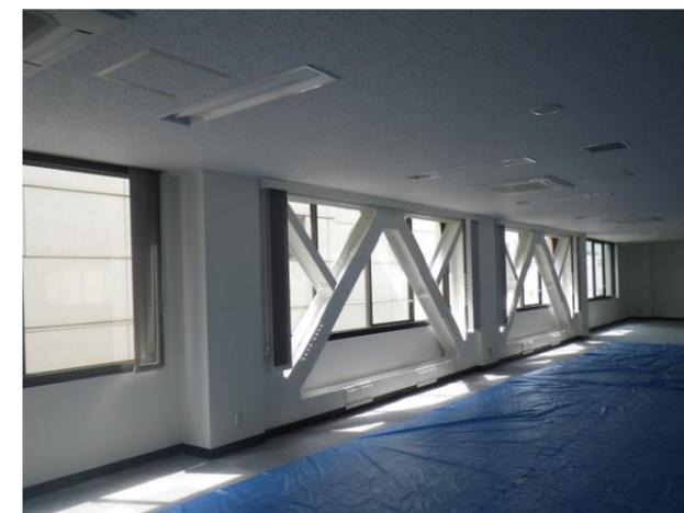
基準階 鉄骨ブレース
