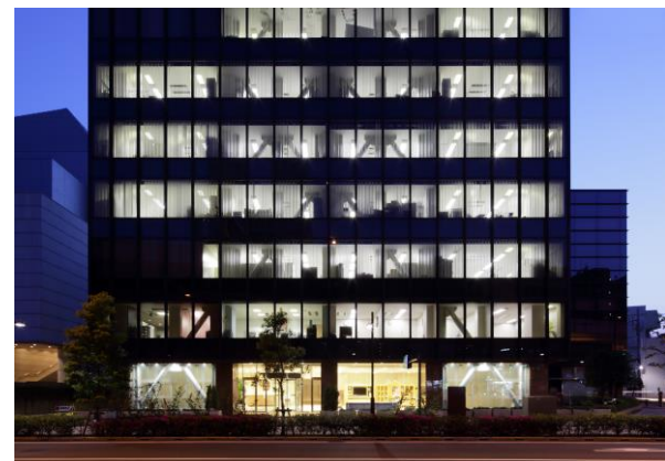
建物外観（補強後） 撮影：株式会社エス東京 齋藤 謙
