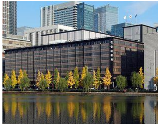
建物外観(改修前後とも)
