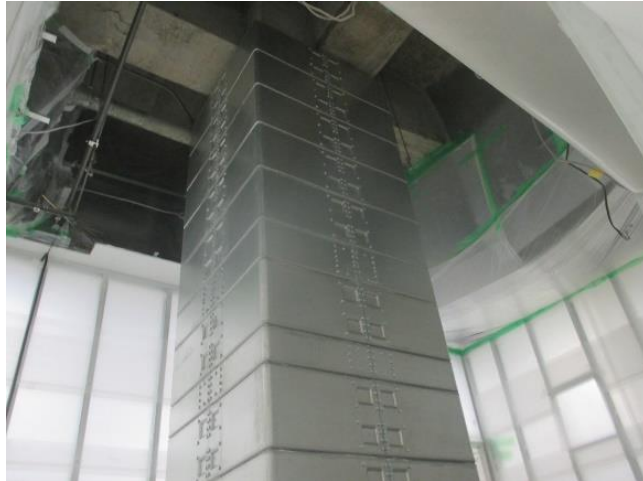
写真-3 改修中 狭小空間での3Q-Column 施工
