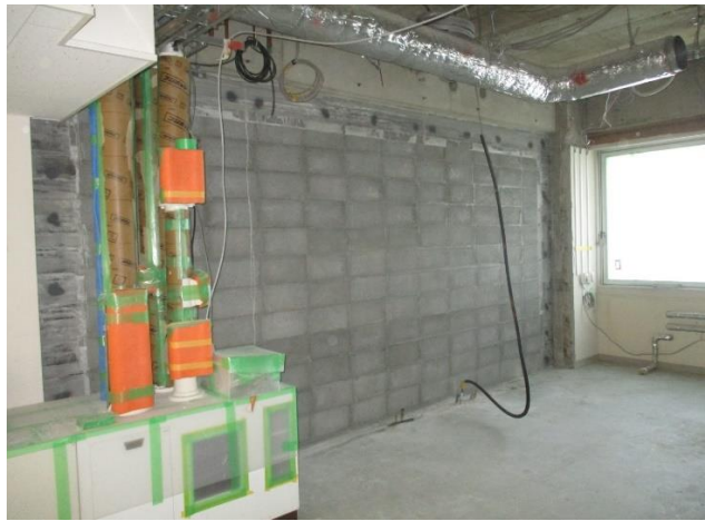
写真-1 改修中 機器を存置したままの3Q-Wall 施工
