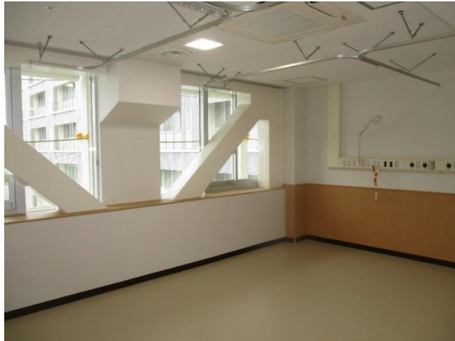
写真-2 改修後 4床病室 3Q-Brace および内装の美装化
