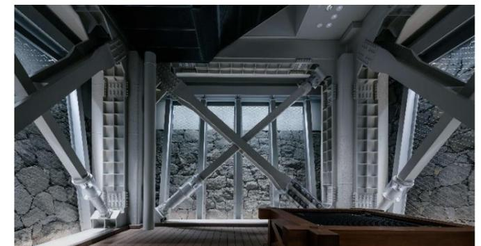
写真3 クロスダンパー設置状況(小天守地下1階)
