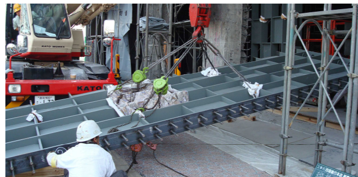
写真5 縦格子耐震壁の建て込み
