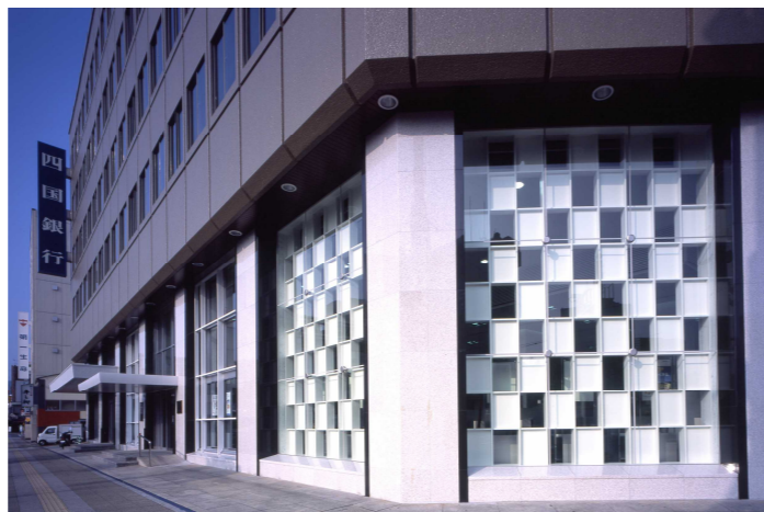
写真2 はりまや橋交差点に面した「縦格子ファサード」
