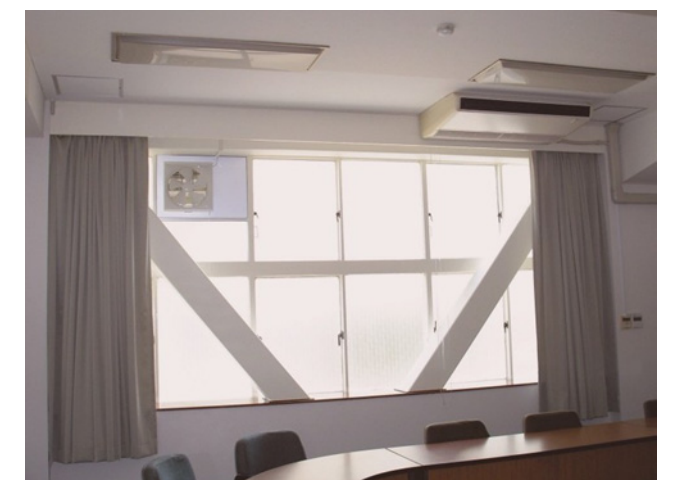
3Q-Brace工法 完了状況
