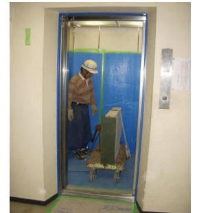
エレベーターでの運搬状況
