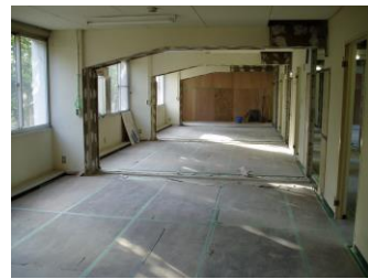
改修前の室内状況(コンクリートブロックの間仕切壁撤去後)
