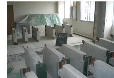
プレキャストコンクリート板の配置
