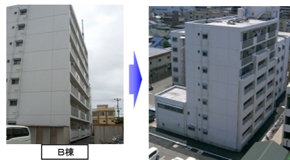
改修前後の建物外観 (改修前の建物と補強フレームが一体化したデザイン)
