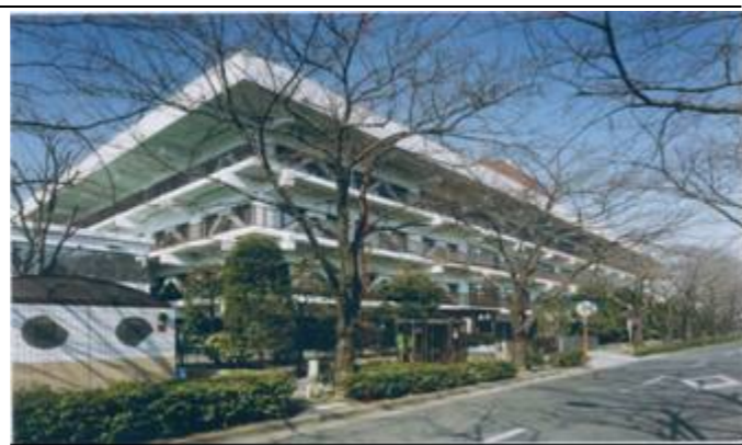
写真-1 総合庁舎本館南東面(制震改修後)
