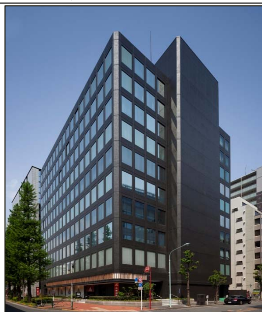
免震改修後の建物全景
