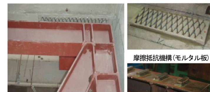
摩擦抵抗機構設置状況(モルタル板設置)
