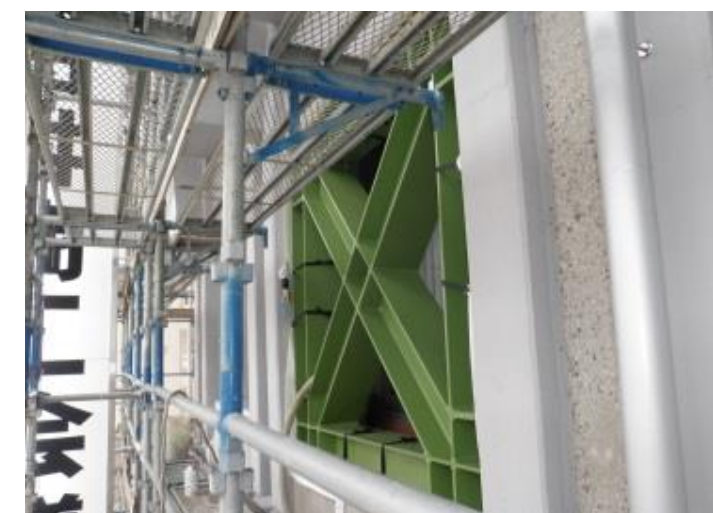
摩擦抵抗機構設置状況(モルタル板設置)
