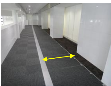
新設 EXP. J 及び新設柱
